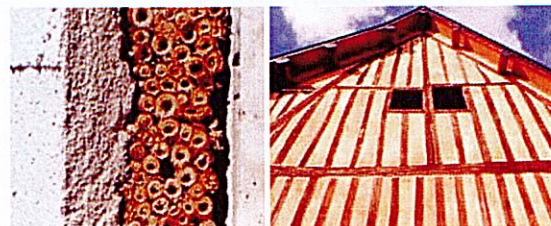
chanvre banché et panneaux enduits
