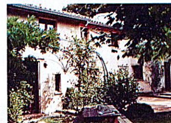
isolation intérieure en chanvre et enduits extérieur chaux
