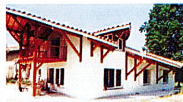
monomur de terre cuite et laine de cellulose en toiture.
