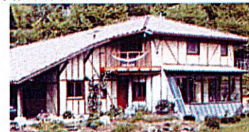
colombage châtaignier et remplissage briques de terre crue comprimée.
